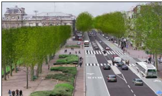
里尔市自由大道上采用的双侧专用车道（源自：里尔市政府“LMCU”）
