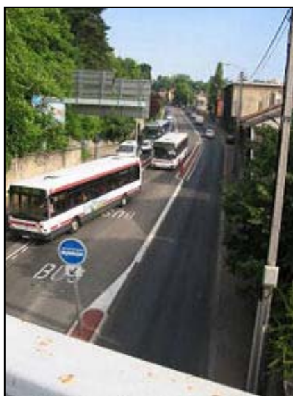
里昂市卡吕尔屈尔区“MontédesSoldats”处根据时间不同规定行车方向的交错式专用车道（源自：法国国家交通技术研究中心）
