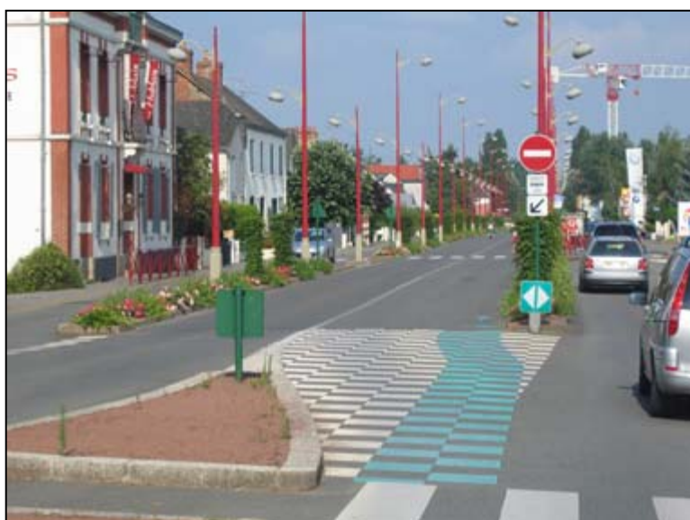
雷恩市一条轴向定位的专用防护路段，用于限定外部相对混乱的交通状况，并清晰地呈现出不同的道路使用权。（源自：法国国家交通研究中心）
