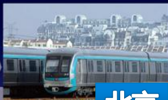
北京4号线、大兴线 2009年
